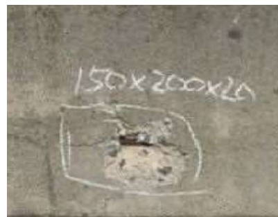
補修：断面修復工法
