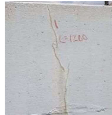
補修：ひび割れ注入工法
