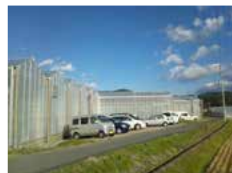
ハウスの外観
