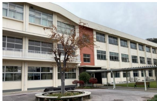
外部改修後（令和6年12月）
