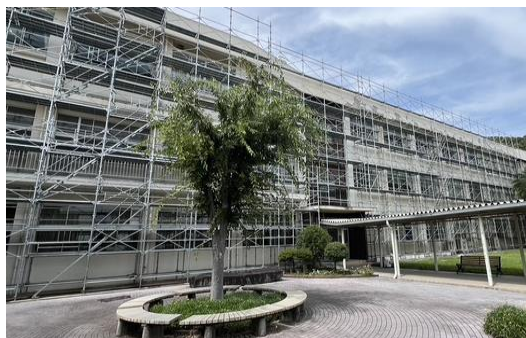
外部改修前（令和6年7月）
