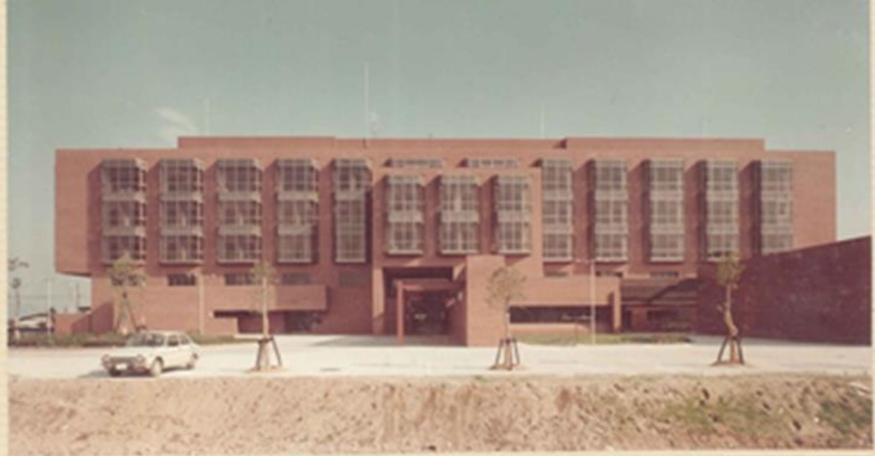
本館正面全景
