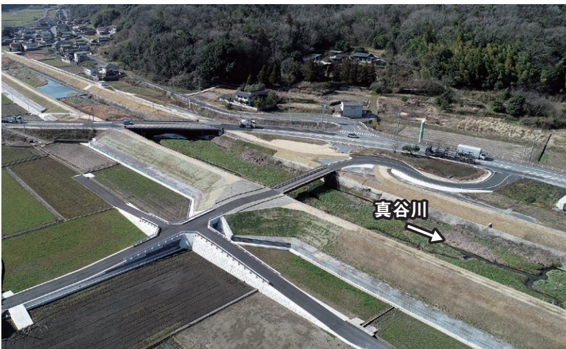
かさ上げや堤防拡幅工事が完成した真谷川＝令和6年3月
