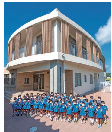
まさびの里保育園の新園舎が完成し保育再開＝令和3年11月1日
