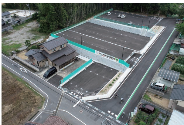
岡田小学校周辺の避難地・避難路整備工事が完成＝令和5年3月16日
