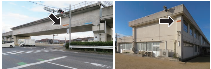
井原鉄道の高架（吉備真備駅近く）や小学校の外壁に引かれたオレンジライン。写真左の右にあるブルーラインは平成30年7月豪雨の実績浸水深
