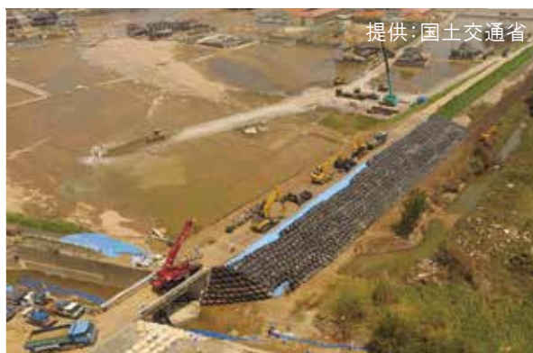
小田川左岸の大型土のうによる仮堤防(3k400)
