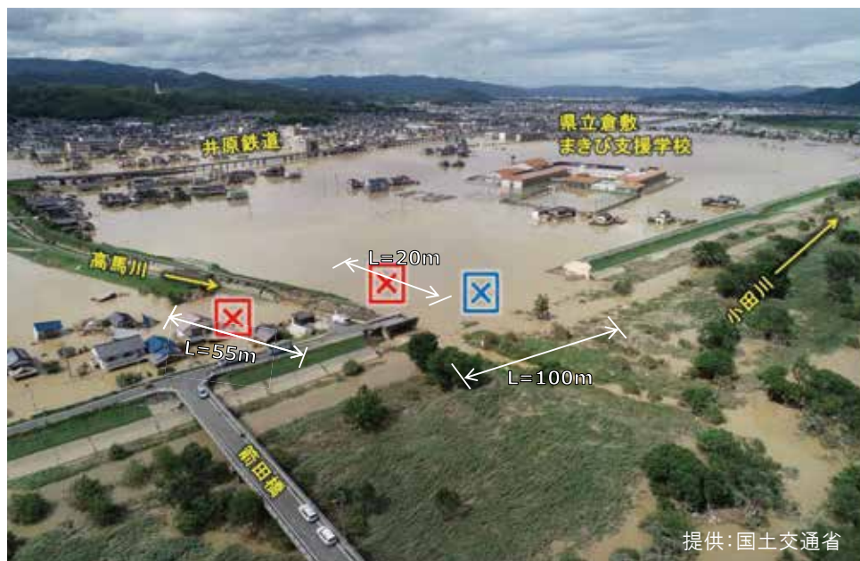
緊急復旧工事（仮復旧）の様子
