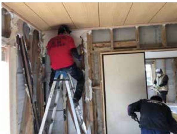
天井・壁剥がし
