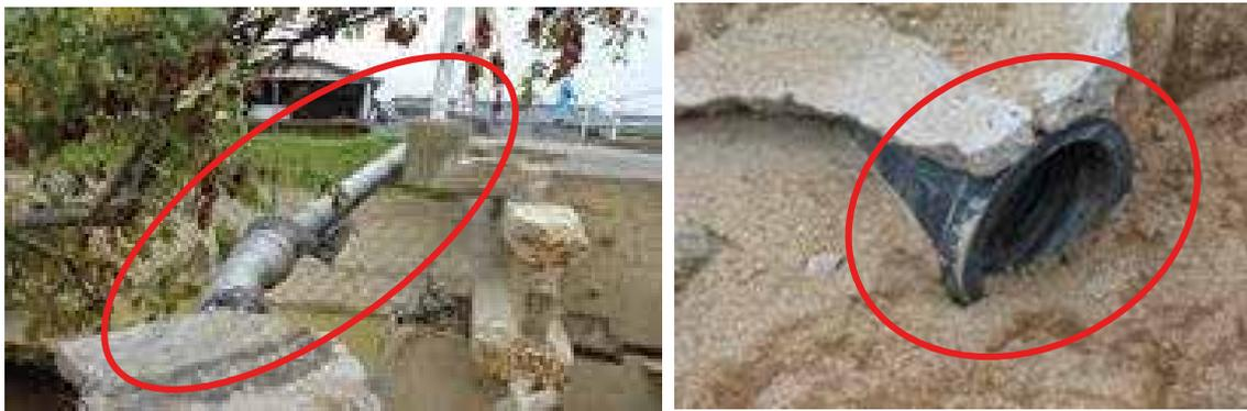
[道路崩壊による管路露出(真備町市場地区)]
