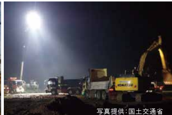
照明車を投入し、小田川堤防決壊復旧作業を24時間体制で実施
