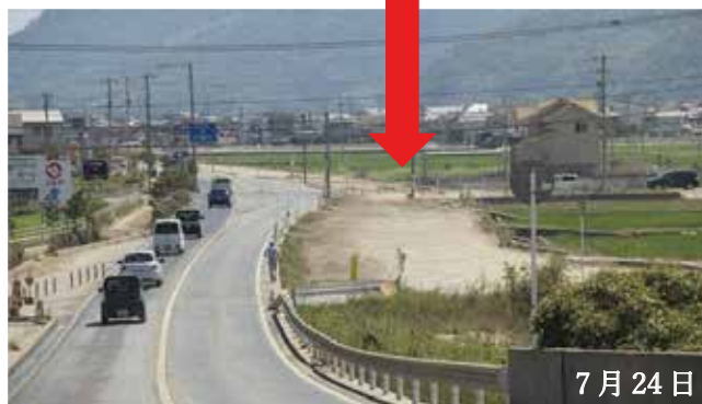
廃棄物撤去が撤去された国道 486 号
