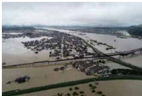
ドローンによる被災調査（施設被害・浸水被害）
