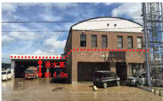
浸水した真備分署(7月9日)
