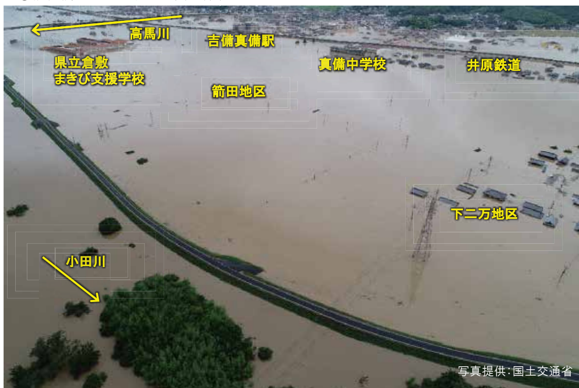
⑨福松橋上空から北西方面を撮影
