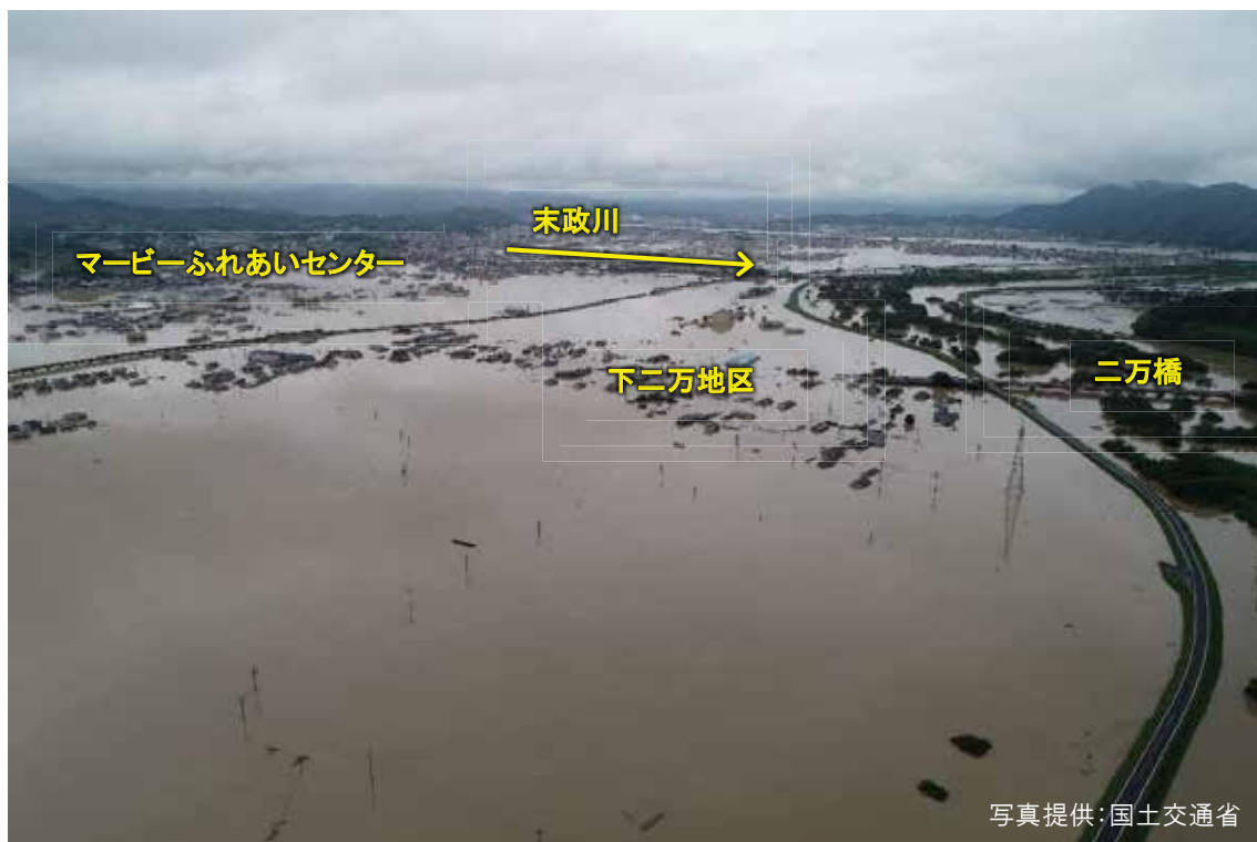
⑧福松橋上空から北東方面を撮影
