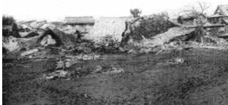
明治26年 家屋倒壊状況(真備町川辺字辻尾)
