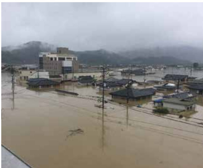
真備支所から吉備真備駅方面を撮影
