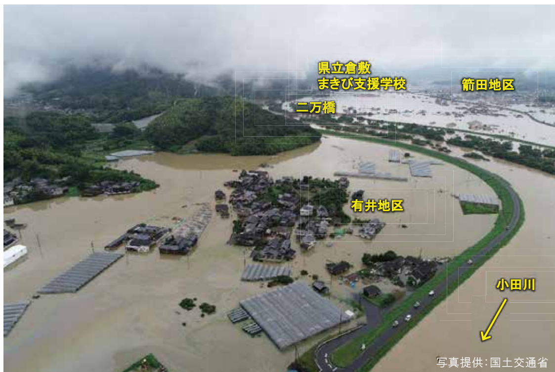
④矢形橋上空から南西方面を撮影
