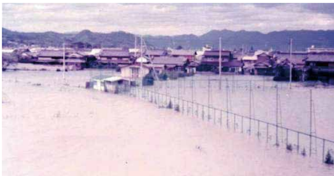
昭和51年 内水による浸水状況(真備町川辺)
