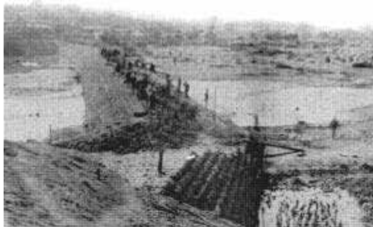
明治26年 堤防決壊の復旧状況(真備町川辺)
