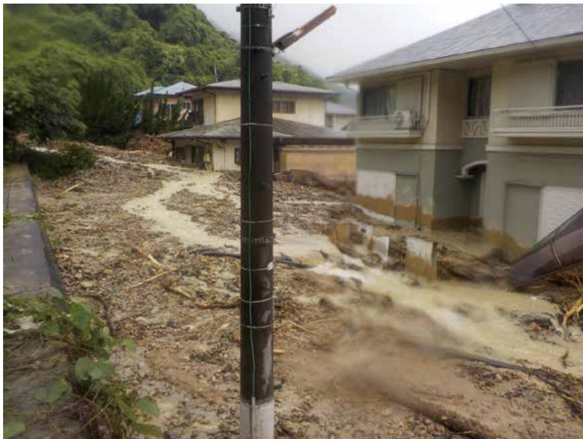
コスモタウン広江の土砂災害 被害状況
