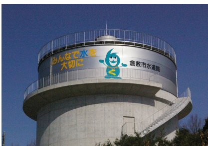
▲耐震性のある高架水槽
