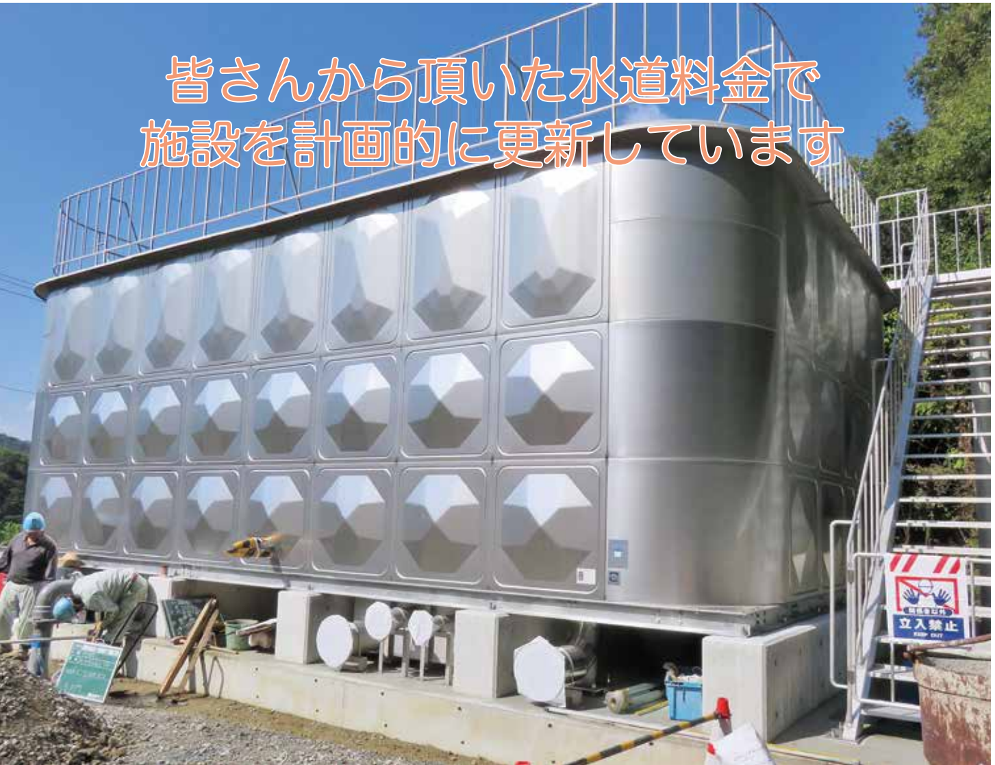
▲工事中の尾原配水池
