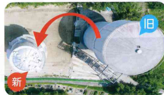
▲新旧の味野高架水槽を上から見た様子
