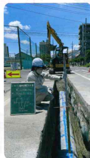
▲地震に強い水道管に交換
