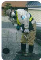
▲漏水調査の様子
