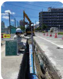
▲地震に強い水道管に交換
