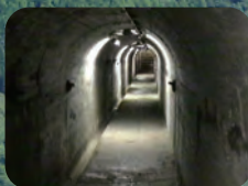
▲ダム内部の点検用通路の様子
