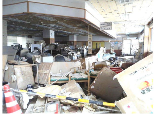
真備保健推進室内（1階）
