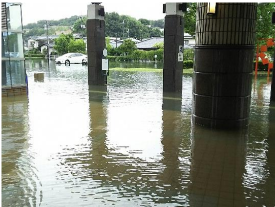
倉敷市保健所建物周囲も冠水（7月7日朝）
