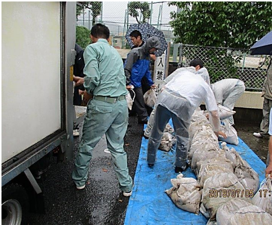
事前に地下へのスロープ前に土のうを設置
