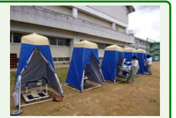
マンホールトイレ（緊急トイレ）
