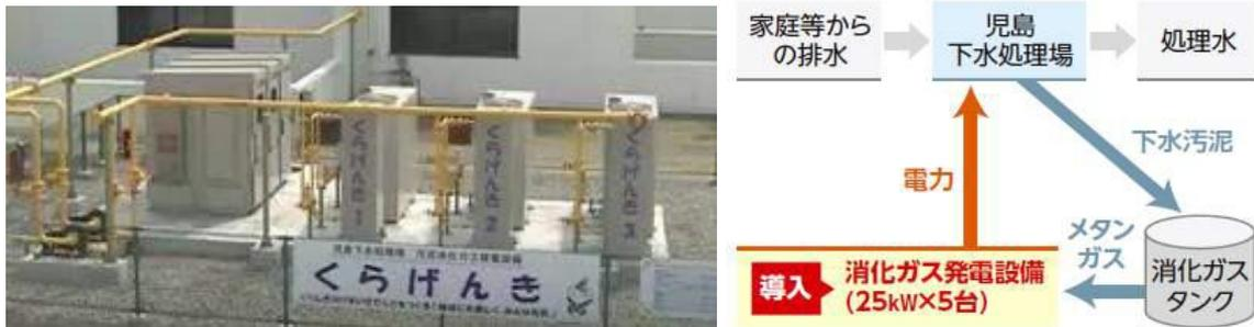
▲消化ガス発電設備(愛称:くらげんき)(左)と設備の概要(右)
