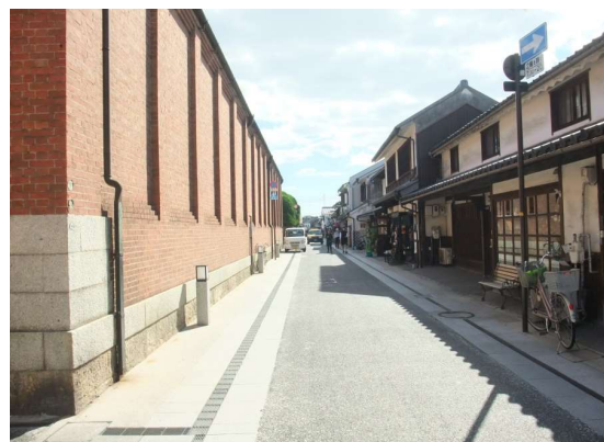
図6 無電柱化状況（本町16号線）
