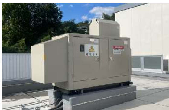
(非常用発電機や受変電設備は屋上など影響を受けない場所への設置を検討)
