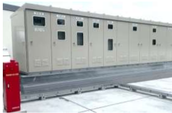
(非常用発電機や受変電設備は屋上など影響を受けない場所への設置を検討)
