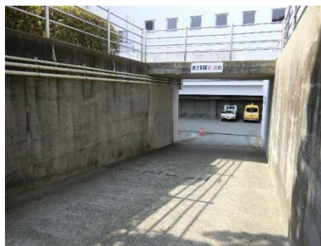
図 解体予定のブリッジ
