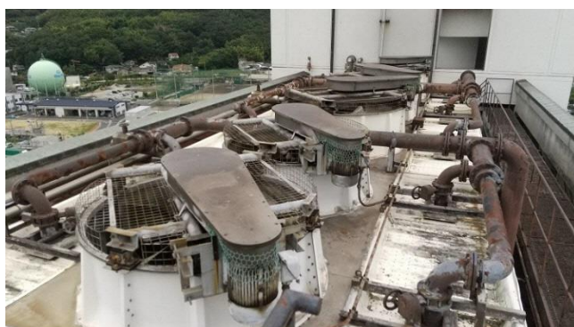
図 高層棟屋上の現況
