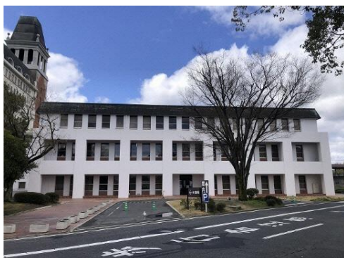
図 低層棟の窓(現況)
