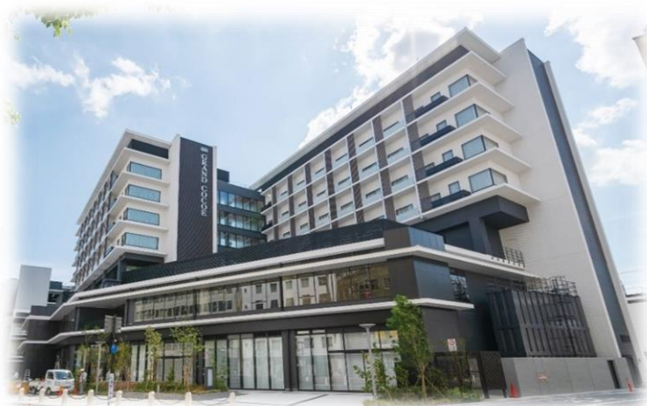
令和3年10月にグランドオープンした あちてらす倉敷
