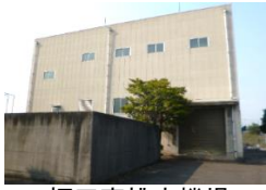
福田東排水機場
