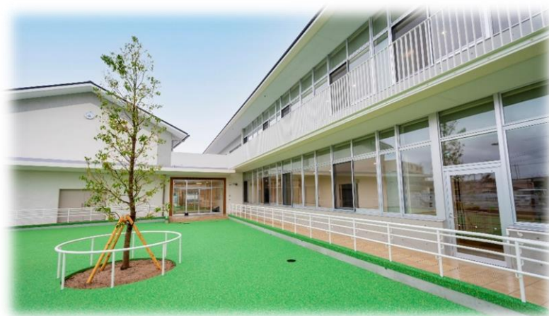
令和4年11月に移転オープンした 倉敷北児童センター
