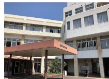
倉敷労働会館（築48年）
