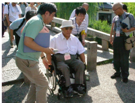
図 2-4 自力で移動が困難な段差がある。(中橋)
