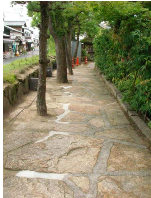
車いす使用者等の通行に配慮して目地の埋め込みがされている。
