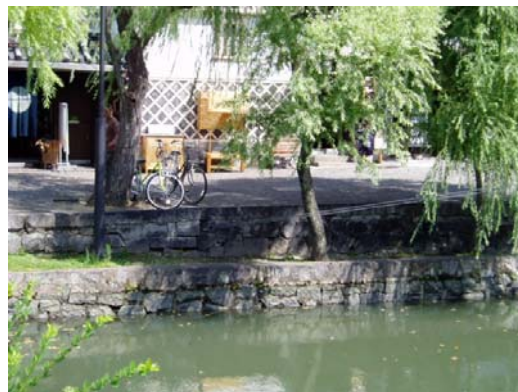
図 2-13 倉敷川への転落の危険がある。
