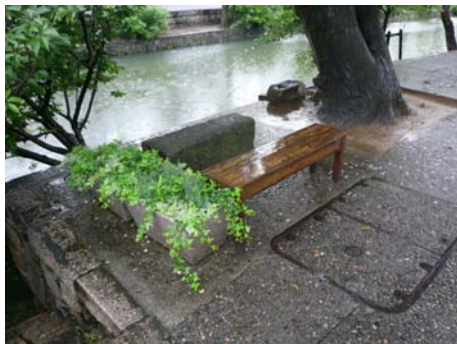
図 2-7 倉敷川沿いには転落防止柵がない。 （転落防止を兼ねて設置されたフラワーポット等）
