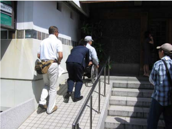
スロープが設置されていても、急な場合は適切な 介助が必要である。
