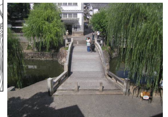
中橋の段差の改善
