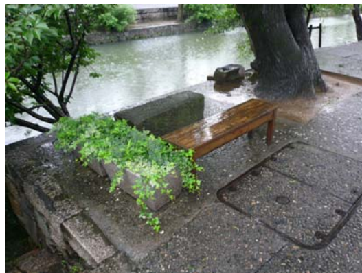
図 6-2 転落防止を兼ねている フラワーポット
