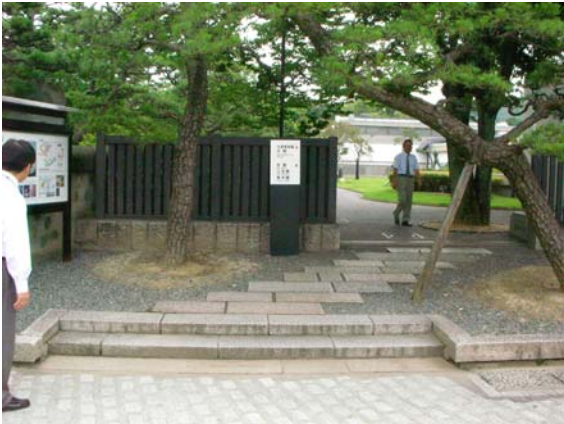
段差（2段）があり、車いす使用者等は介助なしでは入場できない。 （大原美術館西門）
