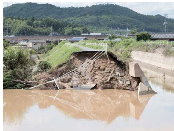
被浊流冲垮的堤防 决堤后，房屋里转眼间就会浸水。决堤处附近的房屋就会或者流进泥沙，或者受到损害 ...
