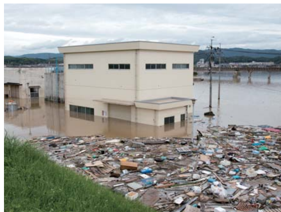
被浊流冲走的家具什物 水灾中，被浊流冲过来的不仅仅是家具什物，还有泥沙和污泥。这些是产生恶臭的原因...
