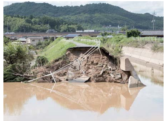
濁流により決壊した堤防 堤防が決壊すると、あっという間に家屋への浸水が進みます。決壊か所付近では、土砂の流入や家屋の損壊が…
