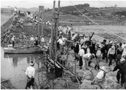
写真2 玉島乙島の堤防修復作業（12-11）
