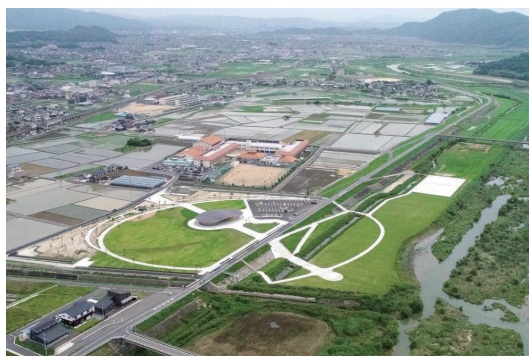
復興のシンボル、まびふれあい公園 平時は防災教育や憩いの場などに、災害時は救護活動や一時避難の場として活用される
