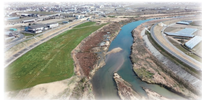
再繁茂抑制のため河川敷地の利用も進める小田川
