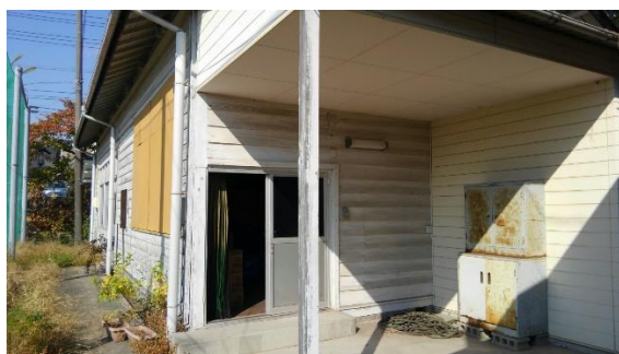
味野倉庫外観
