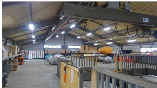
水道局資材倉庫 2 階（片島浄水場）
