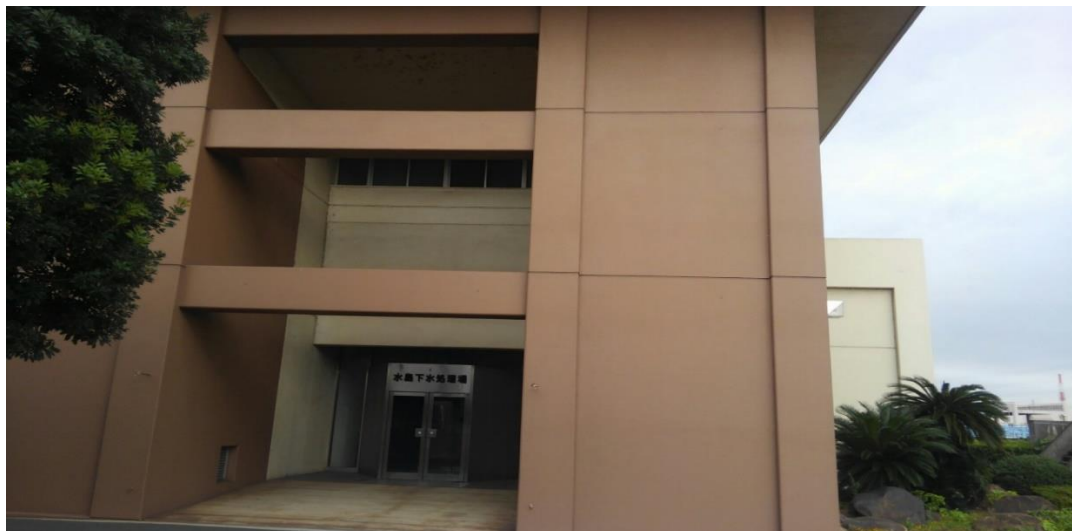
水島下水処理場外観
