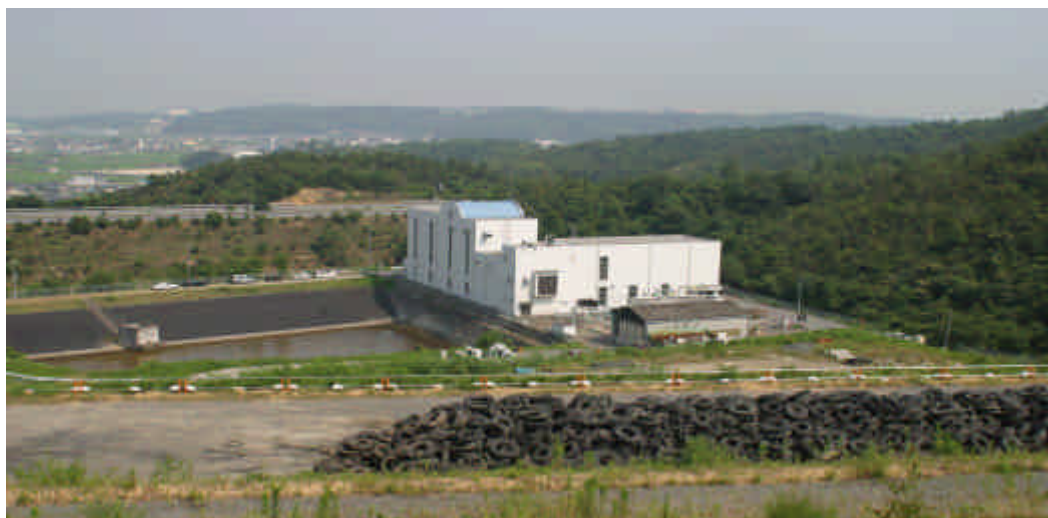
( 埋立場より管理棟を望む )
