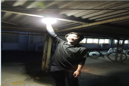
800lmの電灯を設置している様子
