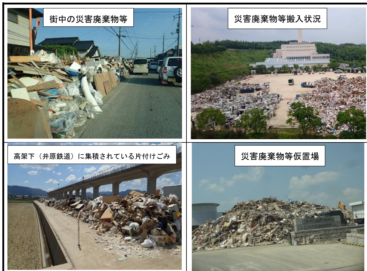
図-3 平成30年7月豪雨による災害廃棄物等の状況
