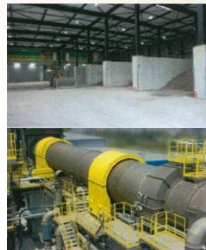
■ 灰受入れヤード
