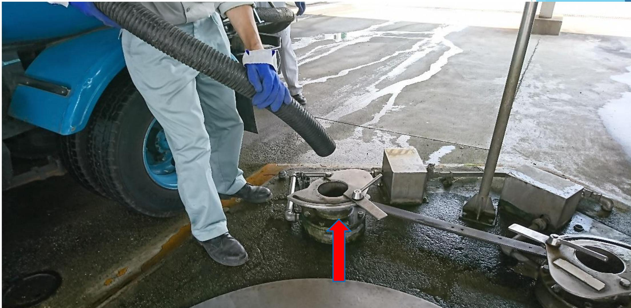
☑児島衛生センターへ戻り、し尿投入槽へし尿を投入しているところ
