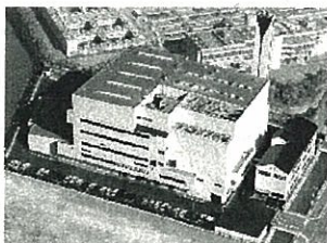
1 水島清掃工場
