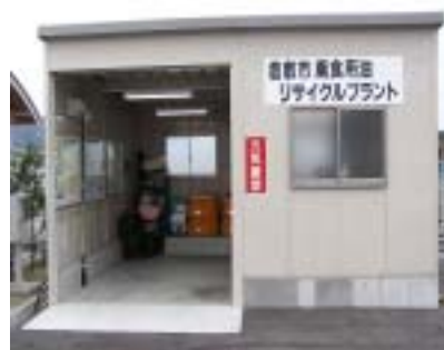
廃食用油リサイクルプラント
