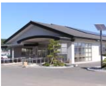
太陽光発電システムの設置 児島リサイクル推進センター(20kW)
