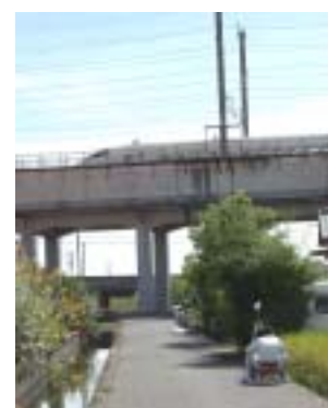
新幹線騒音振動測定
