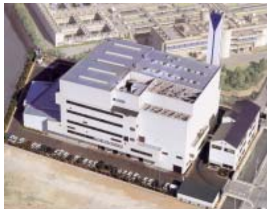
水島清掃工場
