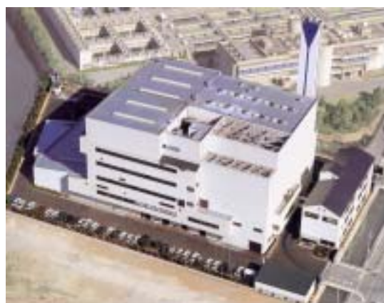
水島清掃工場
