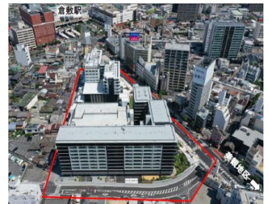
施工後 (R3. 7. 21 撮影)
