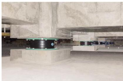
免震構造で建築するとともに、主要設備を上階に配置し、建物出入口には浸水防止ドアを設置しました。災害時に被災者の緊急治療に対応します。
