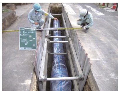
管路の更新工事
