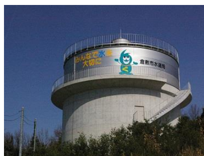
西坂台団地高架水槽
