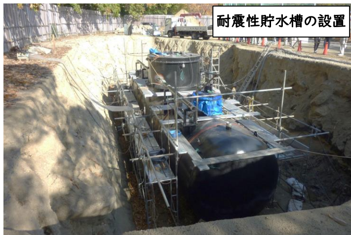
耐震性貯水槽の仕組み
