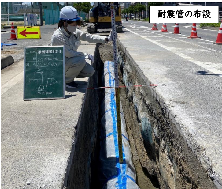
耐震管の仕組み
