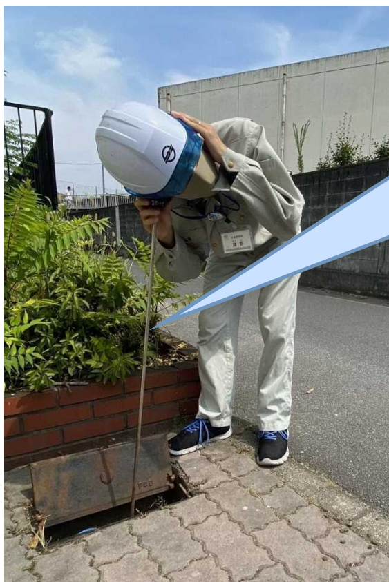
音聴棒による漏水調査の様子
