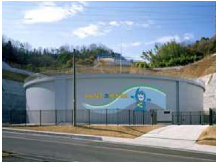
(参考)西之浦第2配水池
