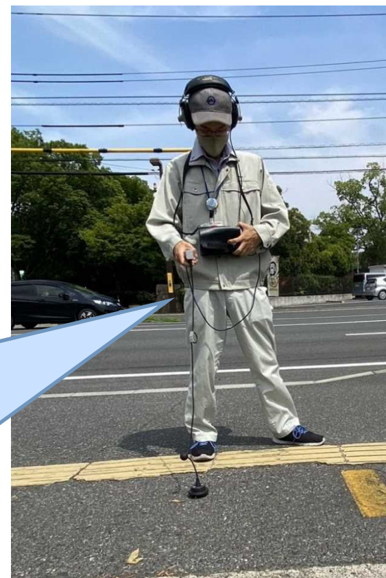
漏水探知器による漏水調査の様子
