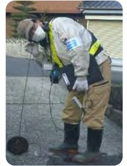
▲漏水調査の様子
