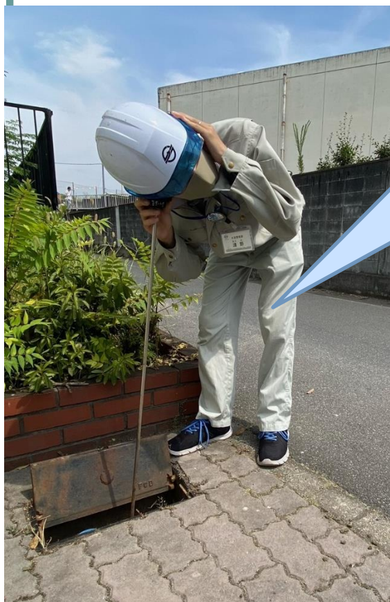
音聴棒による漏水調査の様子
