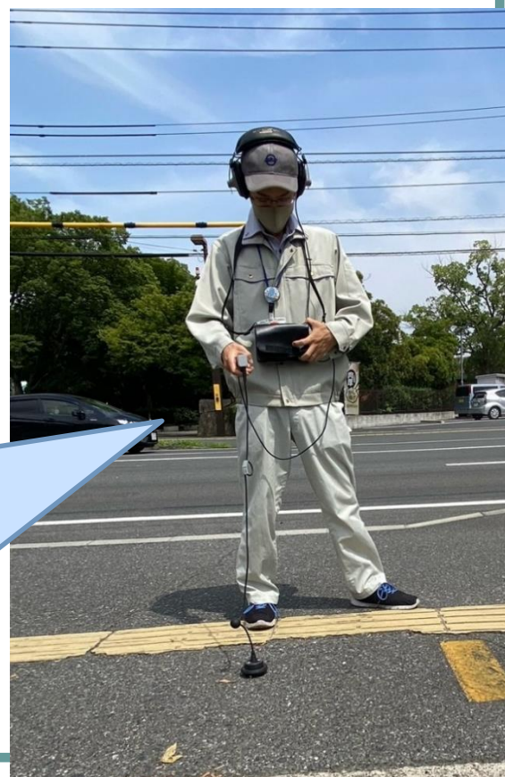
漏水探知器による漏水調査の様子
