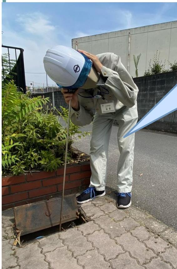
音聴棒による漏水調査の様子
